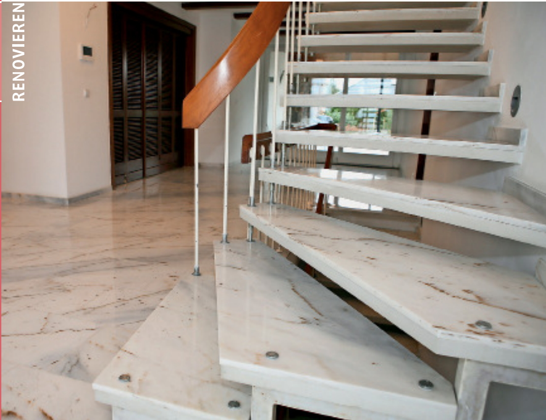
Dieser Marmorboden wurde durch fachgerechte Bearbeitung wirtschaftlich und ökologisch sinnvoll saniert.
