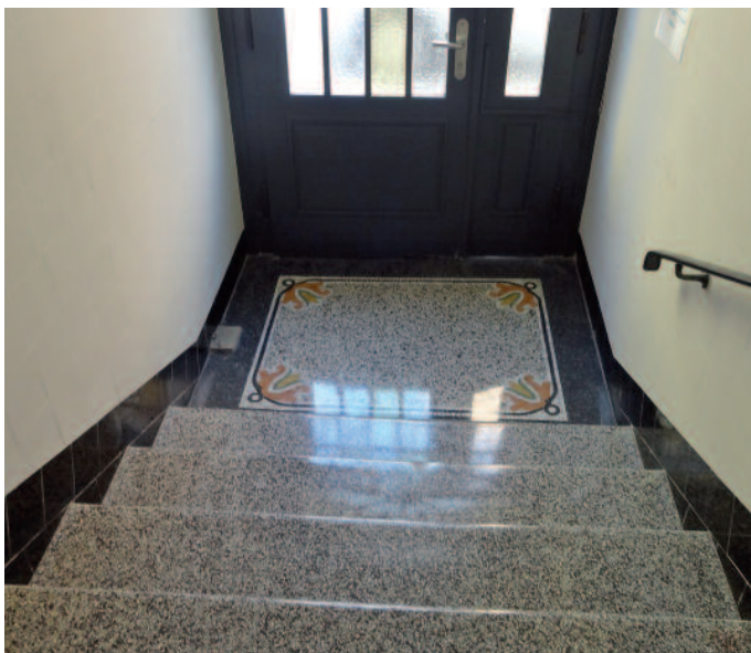
Terrazzo in einem Mehrfamilienhaus nach der Sanierung
