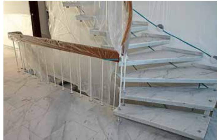
Vor Beginn der Arbeit wurden Geländer und Wände sorgfältig abgedeckt.
